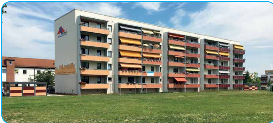
... und nach Abschluss der Umbaumaßnahmen
