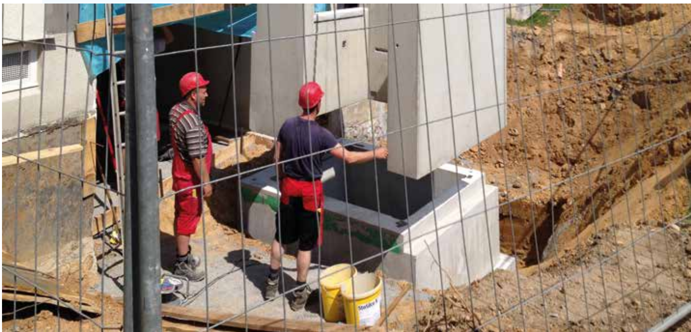
Aufzugsschacht für Keller wird auf die Unterfahrt montiert
