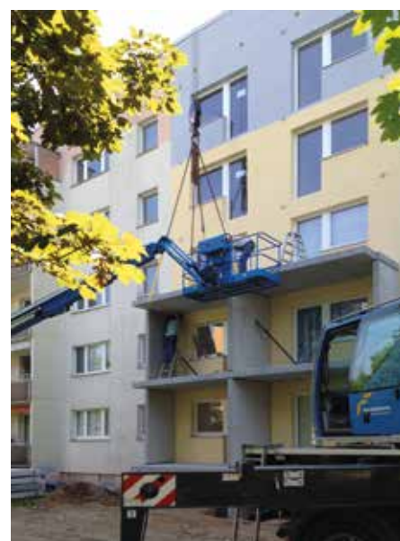
Balkonmontage Doppelturm Westring 12 und 14
